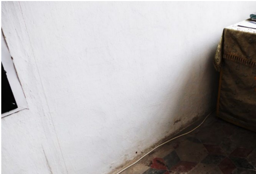
Рис 3.9 – Северная стена центральной апсиды Успенского собора в Рязани с отсутствием визуальных признаков увлажнения и деструкции
