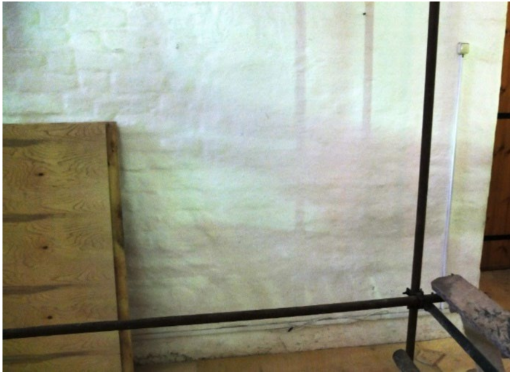
Рисунок 3.8 – Южная часть западной стены четверика Успенского собора на Соловках с отсутствием визуальных признаков увлажнения и деструкции
