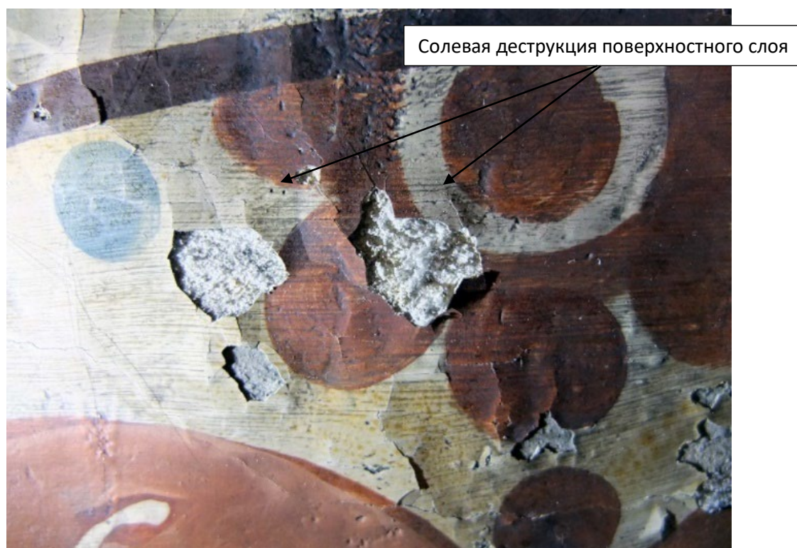
Рисунок 3.4 – Северная часть западной стены Успенского собора Княгинина Монастыря во Владимире. Солевая деструкция поверхности.
