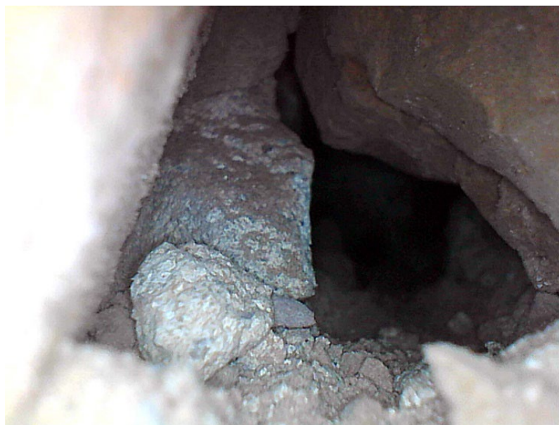
Рисунок 3.21 – Успенский собор в Смоленске. Пустотность в кладке юго-восточной части алтаря на глубине 24,4 см
